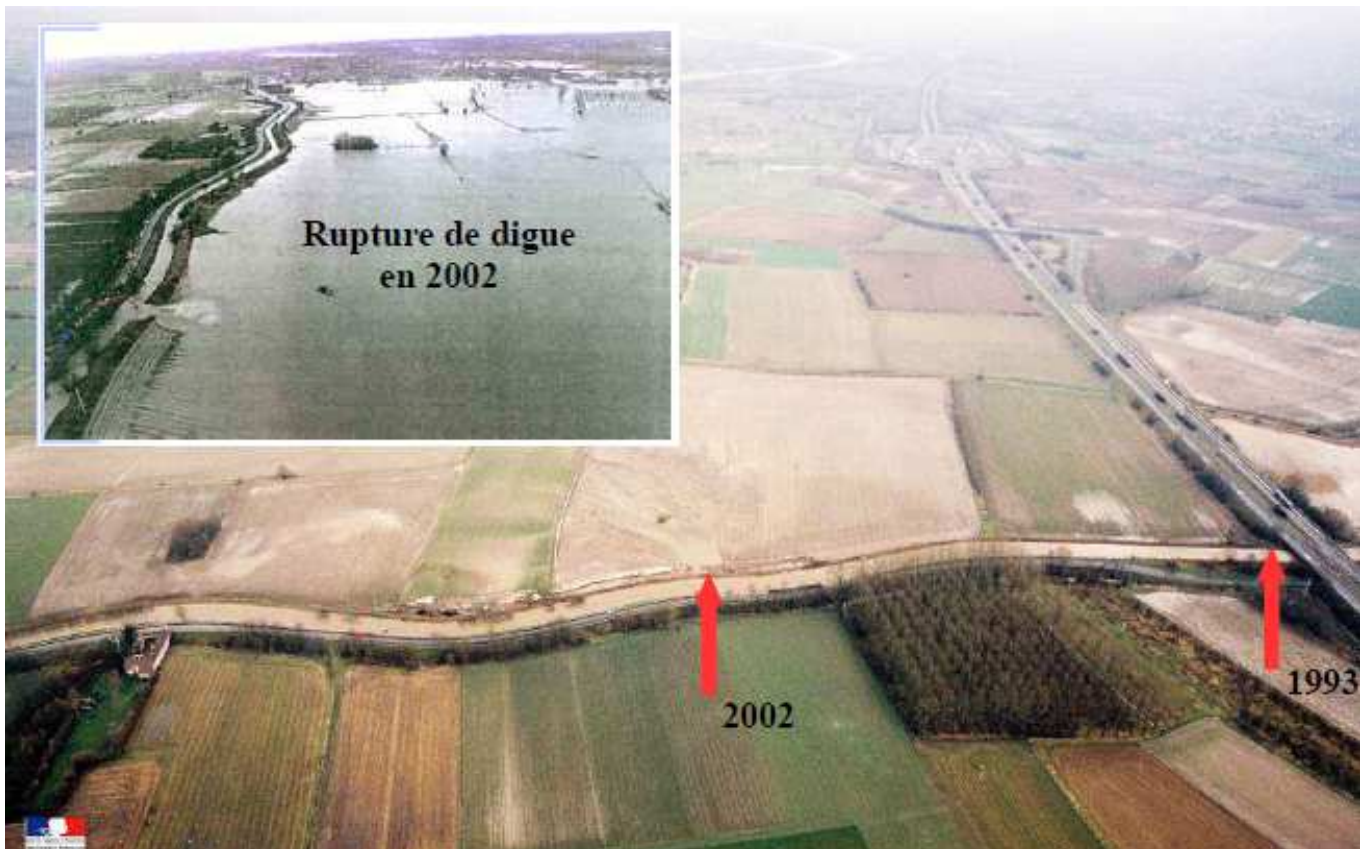
Illustration 15: Localisation de la rupture de digue de décembre 1993 et de janvier 2002. La photo a été prise le 13 février 2002, ainsi l'érosion des terres situées à hauteur de la brèche du 28/01/2002 est encore clairement visible (la brèche est déjà colmatée au moment où la photo a été prise)
